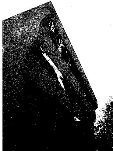
صورة (٢٥٧): منظر خارجي لمكتبة جامعية لاحظ استخدام النوافذ المائلة لتجنب تغلغل أشعة مباشرة إلى المبنى
